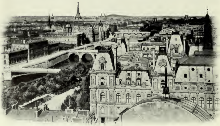
Abb. 6. Blick über die Brücken.
